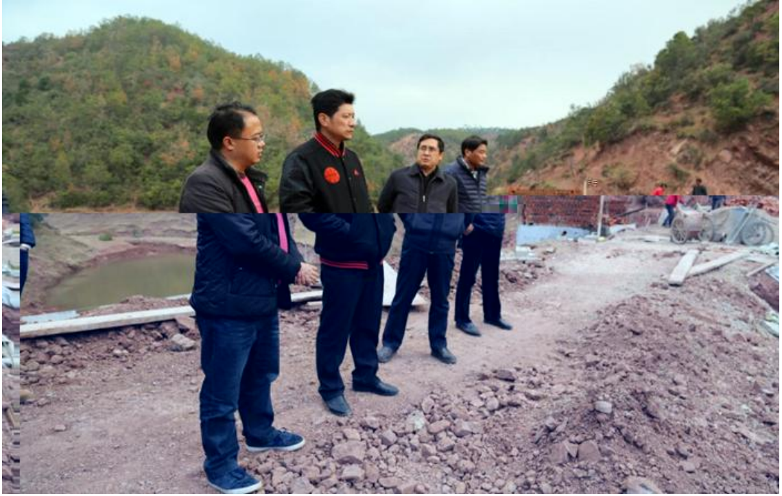
实地查看冷水 水库除险加固工程现场
